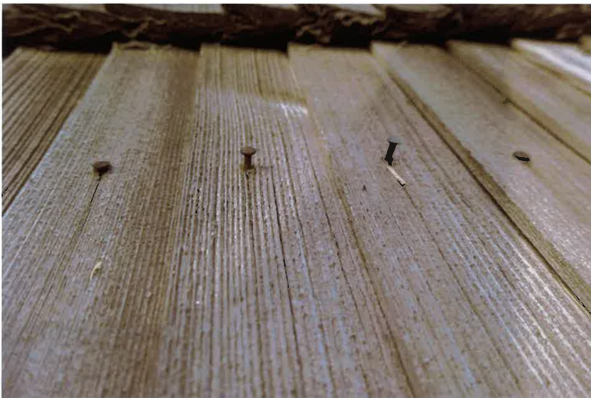
2. Nawa boczna. Strona południowa. Stan zachowania gontów.
