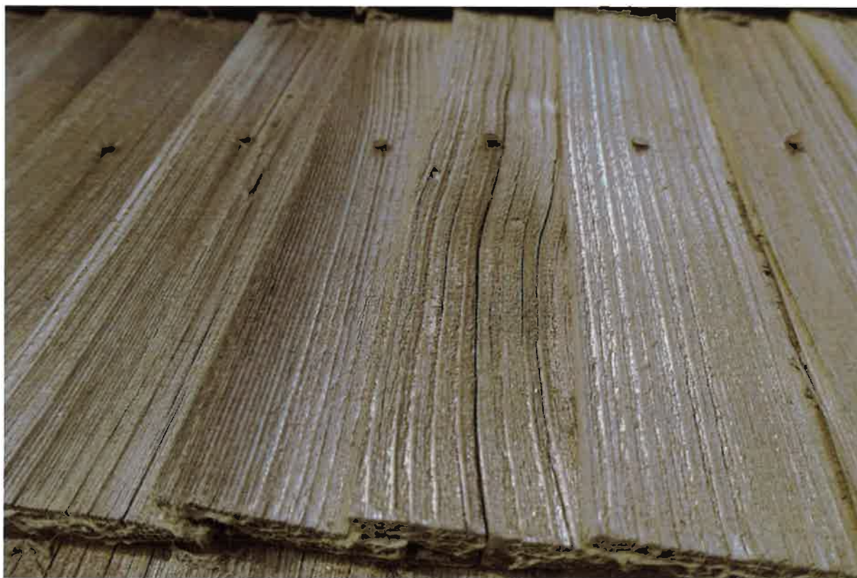
4. Nawa boczna. Strona południowa. Stan zachowania gontów.
