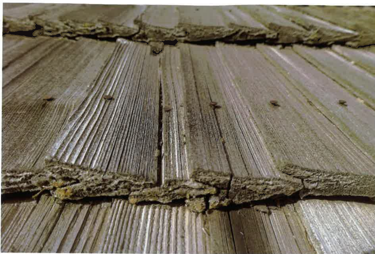
5. Nawa boczna. Strona południowa. Stan zachowania gontów.
